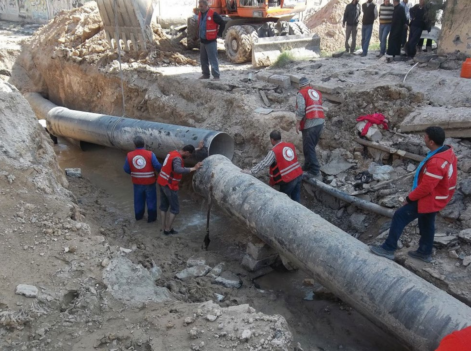
Техническое обслуживание водовода диаметром 700 мм в городе Дейр-эз-Зор, 2014 год. Этот водовод, проложенный от насосной станции Эль-Базель, снабжает многие районы города (около 30 тыс. потребителей). Он был серьезно поврежден в результате военных действий в этом районе. Аварийно-восстановительные работы на линии фронта были проведены после заключения соглашения о прекращении огня. © M. Al Ali/SARC.
