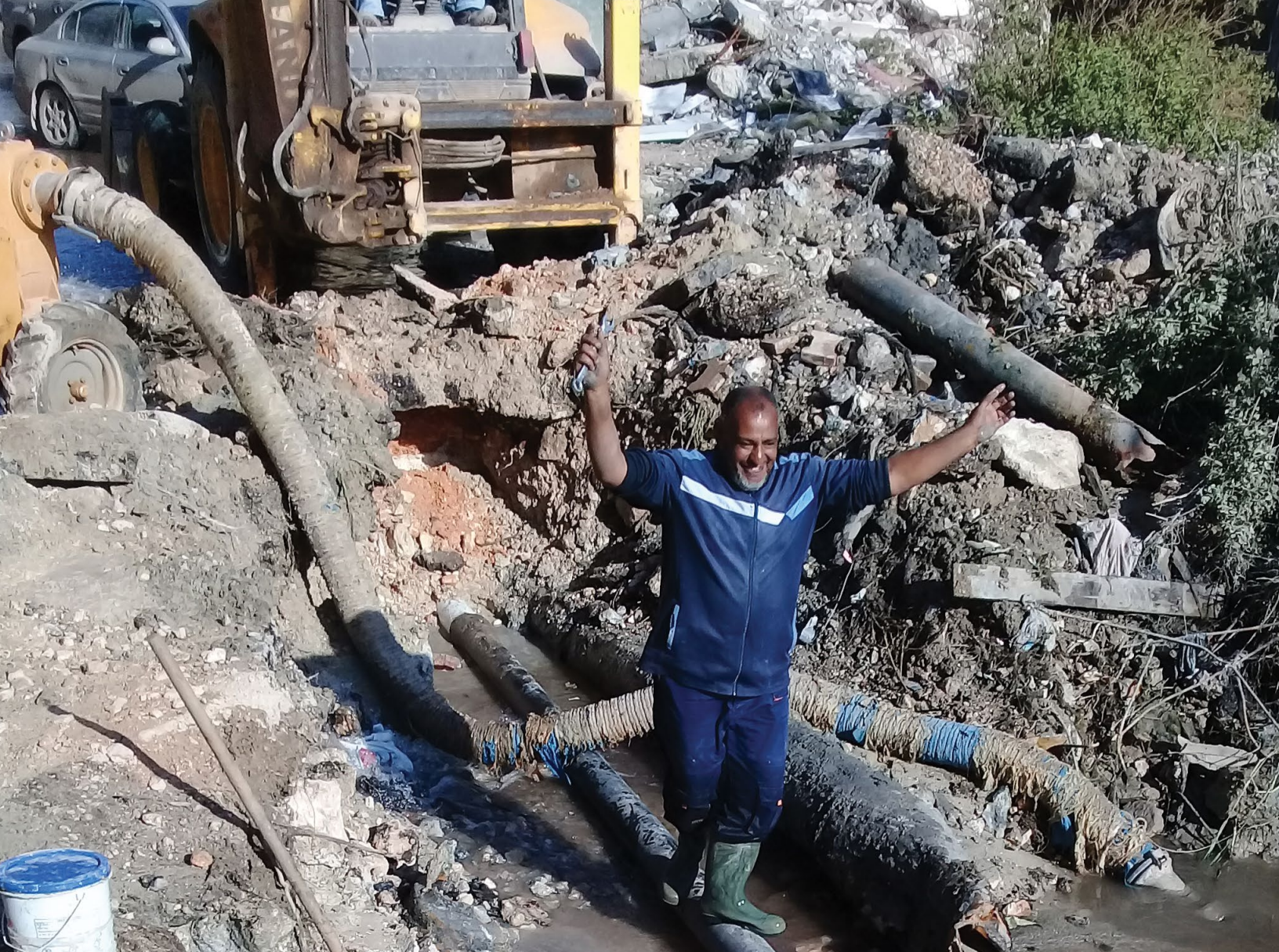
Рабочий Управления водных ресурсов радуется окончанию ремонтных работ на одном из магистральных водоводов, пострадавших в результате военных действий в деловом центре Бенгази, 2018 год. © A. Albarasy/General Company for Water and Wastewater (Libya).
