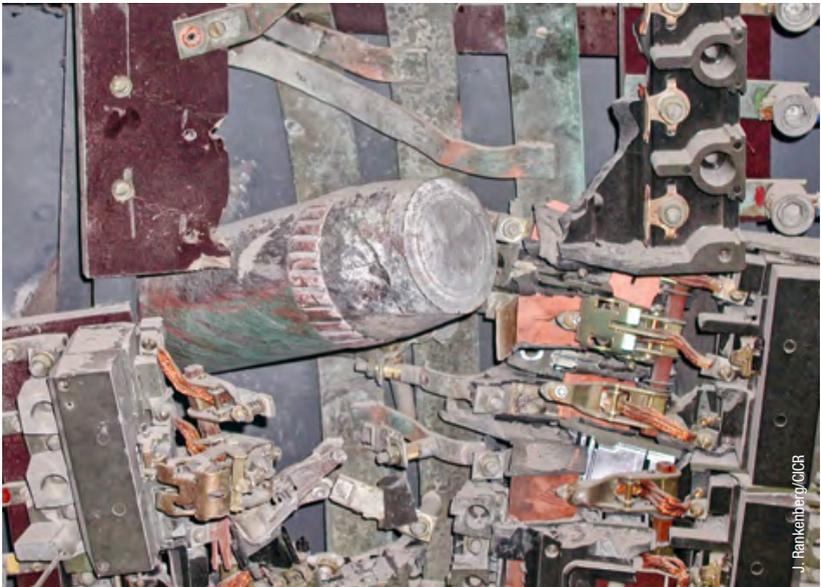
Basra (Irak), 2003 : cet obus d'artillerie de 105 mm, fiché dans le mur d'une armoire électrique d'une station de pompage d'eau dans les quartiers est de la ville, a entraîné la coupure de l'approvisionnement en eau d'une partie importante de la population.
