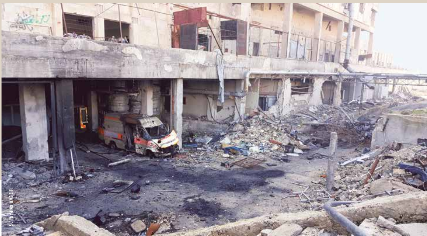
Scène de destruction après des tirs contre l'hôpital national d'Alep. Janvier 2017.
