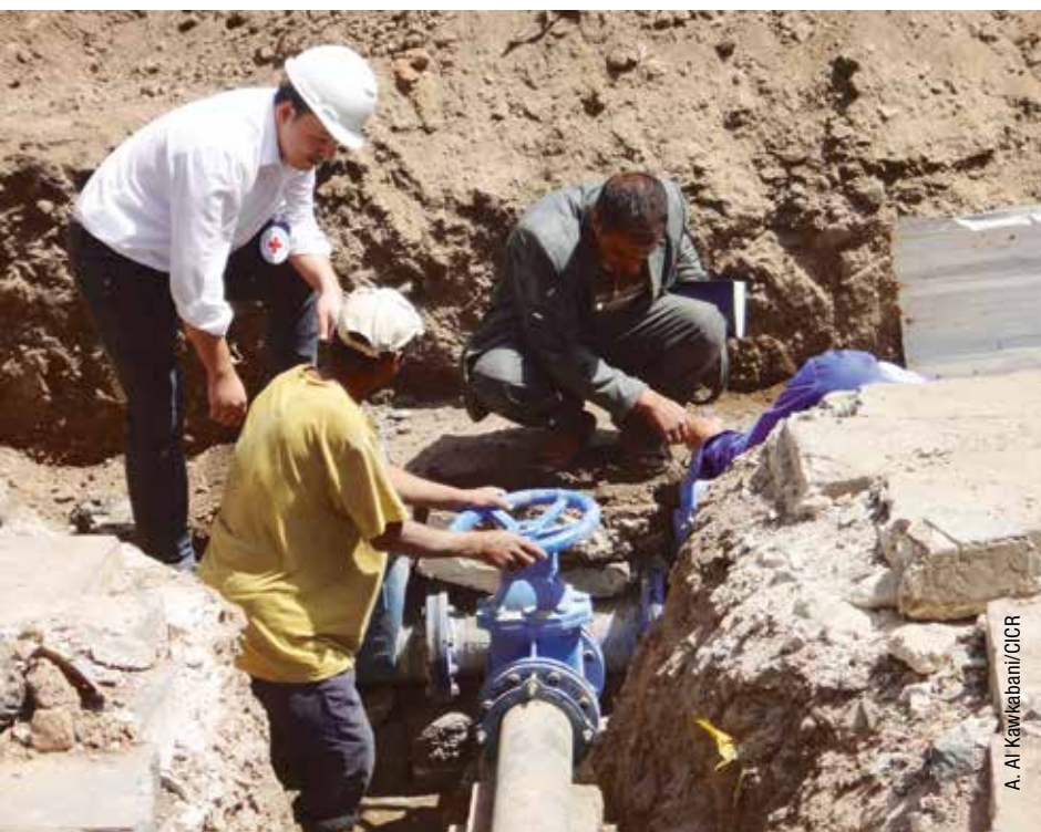
Un ingénieur du CICR et un employé de la régie des eaux locale effectuent le branchement de la conduite d'eau qui alimentera un quartier de la ville de Sanaa, au Yémen. Décembre 2016.
