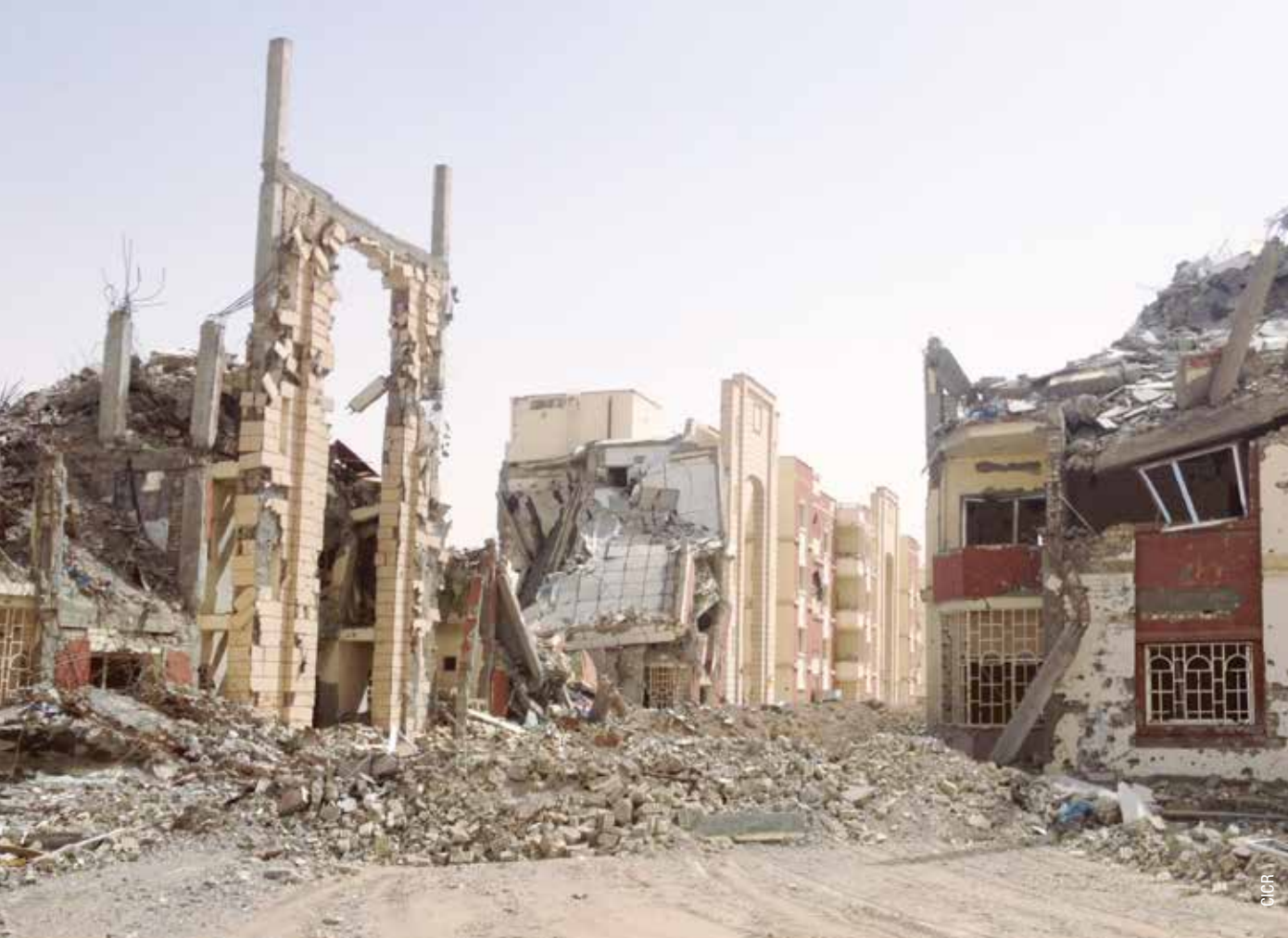
Fin 2015, à Ramadi, en Irak, 80% des bâtiments étaient détruits.
