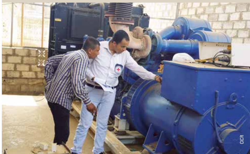
Un ingénieur du CICR vérifie le moteur d'un générateur électrique à l'hôpital al-Thawra, à Hodeïda, au Yémen. Mai 2016.
