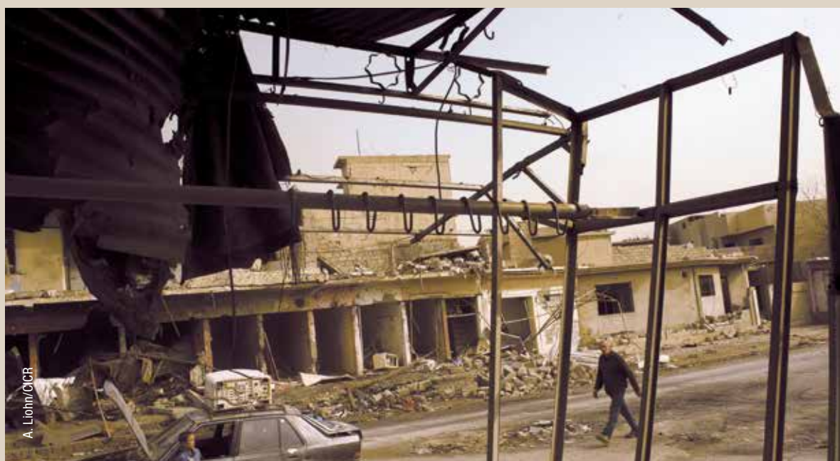
Zone résidentielle endommagée à Mossoul-Est. Février 2017.
